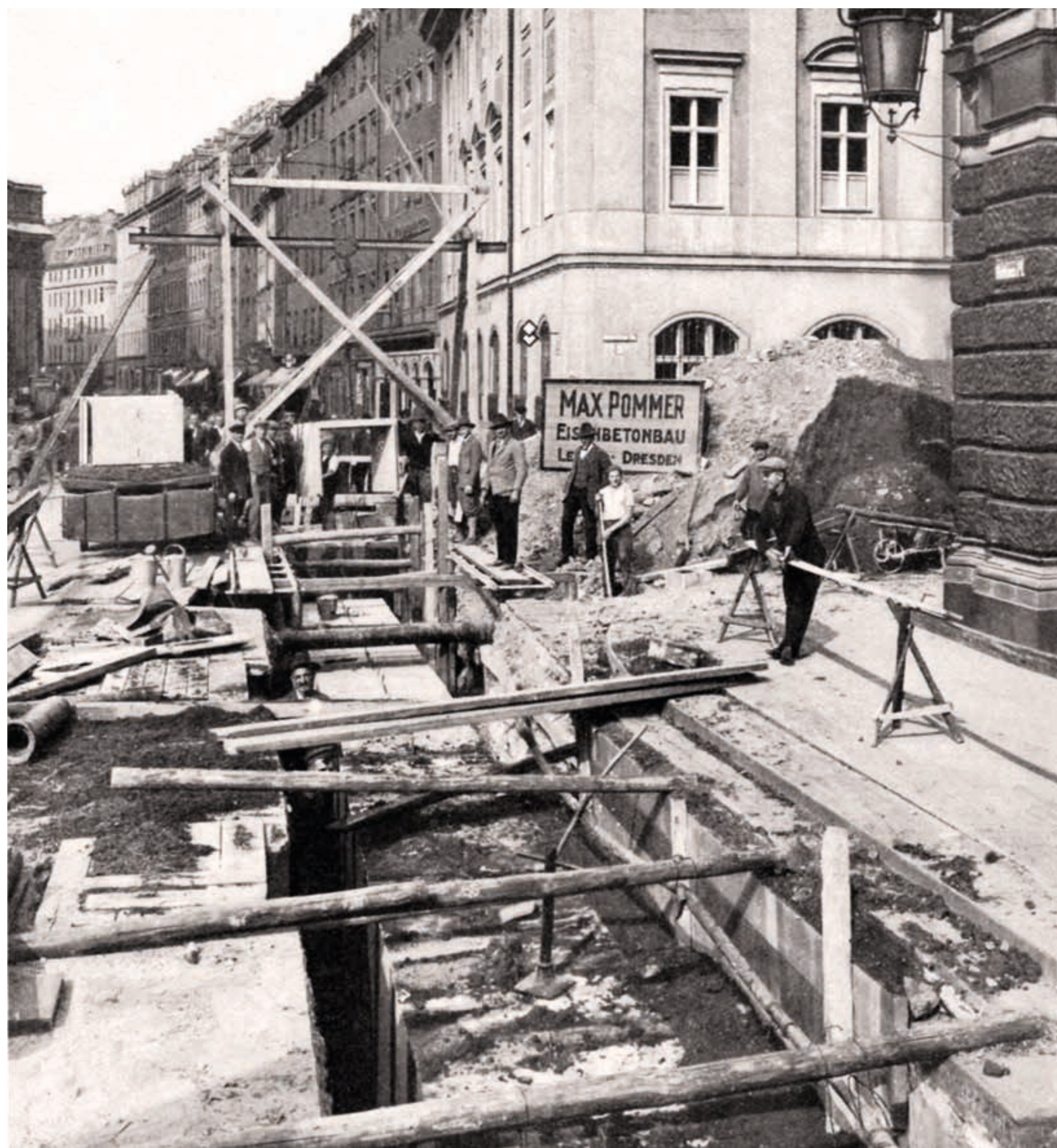
Ausführung eines Fernheizkanals für das Westkraftwerk Dresden, um 1920
